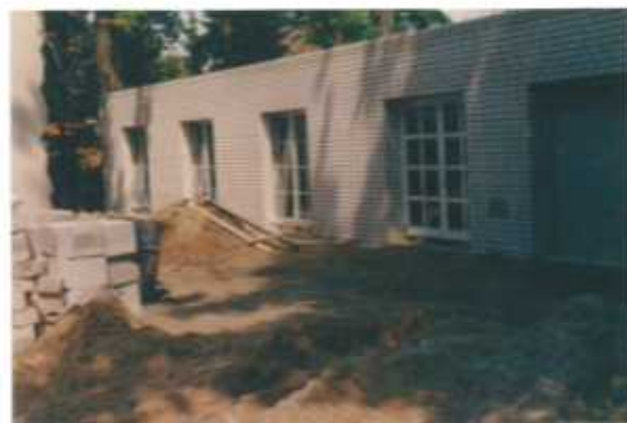
Neubau der Schießsportanlage im Heidewald
